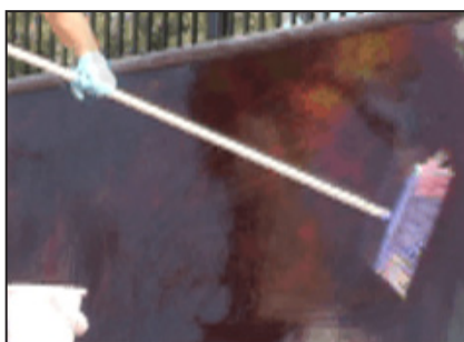
Aplicamos 3 capas de BBSM
