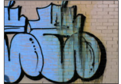
Tras aplicar BBSM, la pintada comenzará a caer por la pared
