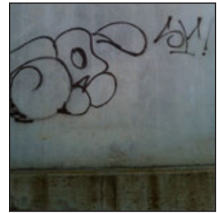
Panel de hormigón
