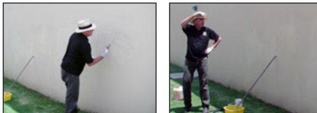
Retoque las áreas restantes del graffiti no disuelto usando SSGR
