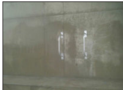
Después de aplicar la solución de muriático
