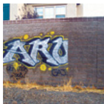
Bloque de Hormigon
