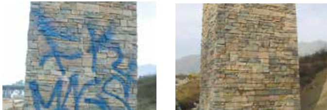
Muros de piedra
